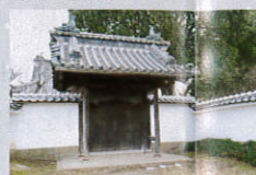
門柱の傾斜・ずれ 袖塀の破損
