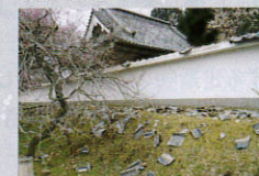
瓦の落下・壁の損傷
