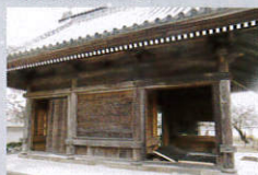
軸部のずれ・戸の脱落
