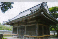
軸部のずれ・戸の脱落
