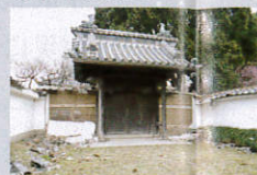
門柱の傾斜・ずれ 袖塀の破損
